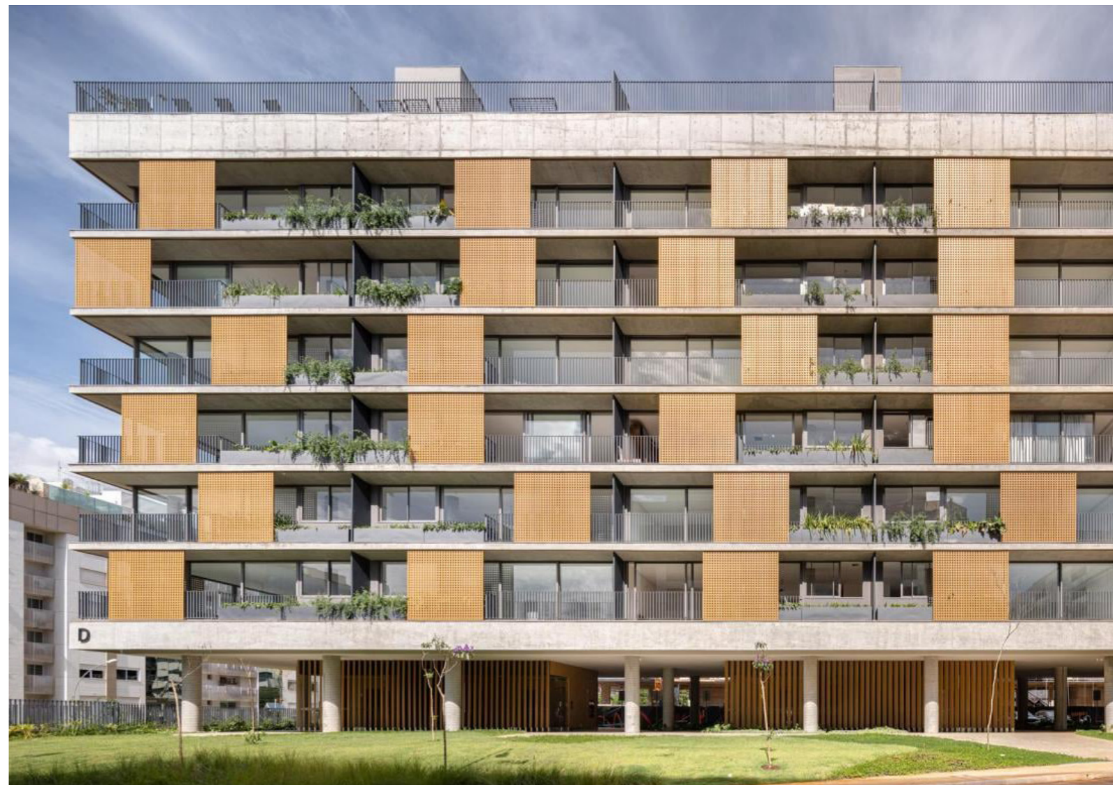
edifício 310 lotus, Brasília .df
