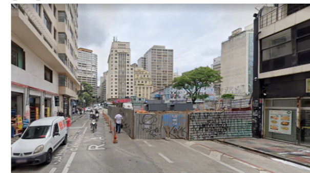
vista a partir da rua antônio de godói, com tapumes de isolamento
