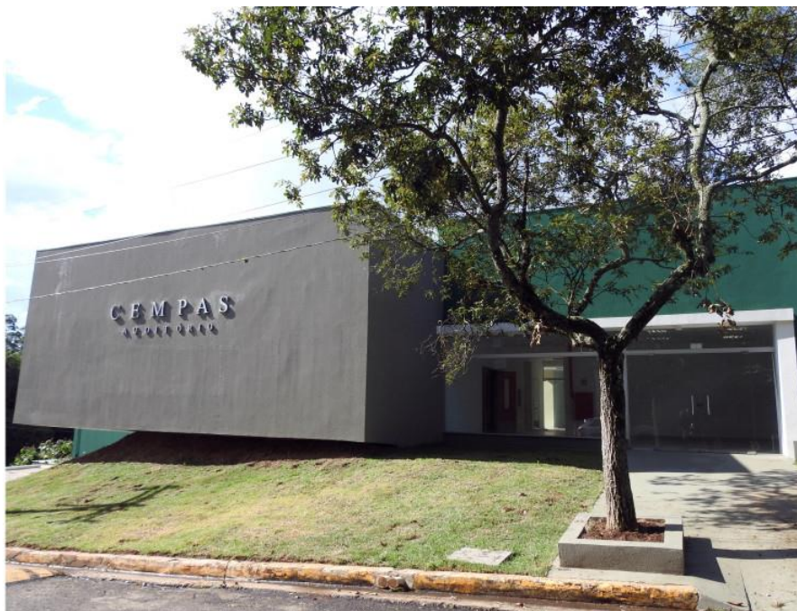
Figura 11. Instalação predial do CEMPAS. Fonte: google imagens.
