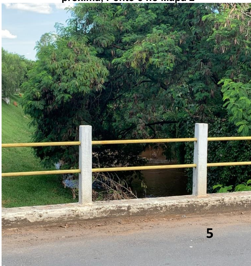
Figura 11 – Ponte que continua a Avenida Araras e a Área de fundo de vale próxima, Ponto 5 no Mapa 2
