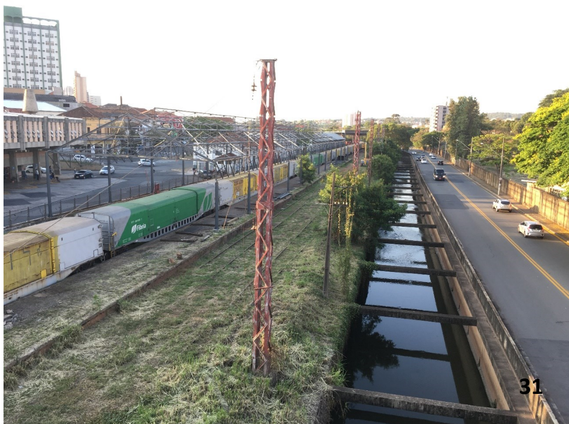
Figura 29 – Trecho do ribeirão que passa atrás do terminal de ônibus, mostrando as estruturas de concreto, visto de cima da Ponte de Pedestres, Ponto 31 no Mapa 2
