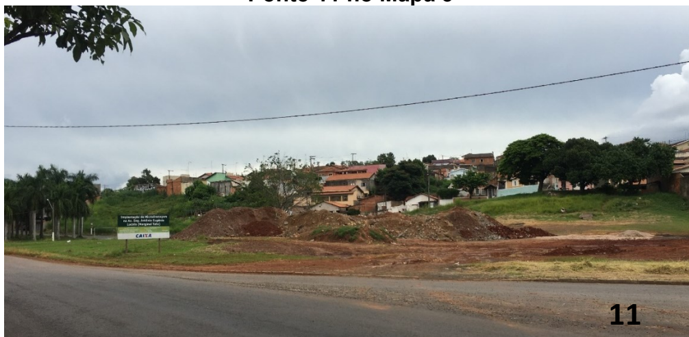
Figura 40 – Obra de drenagem, feita na margem oeste do Ribeirão Tatu, Ponto 11 no Mapa 3
