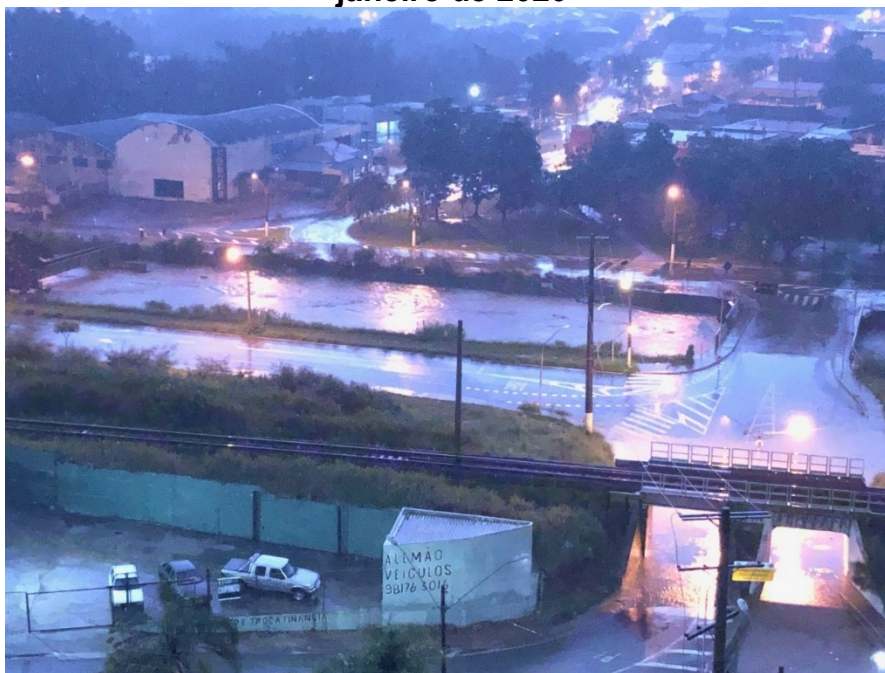
Figura 59 – Área conhecida como Ponte Preta em dia de grande quantidade de chuvas apresentando problemas de drenagem, início de janeiro de 2020
