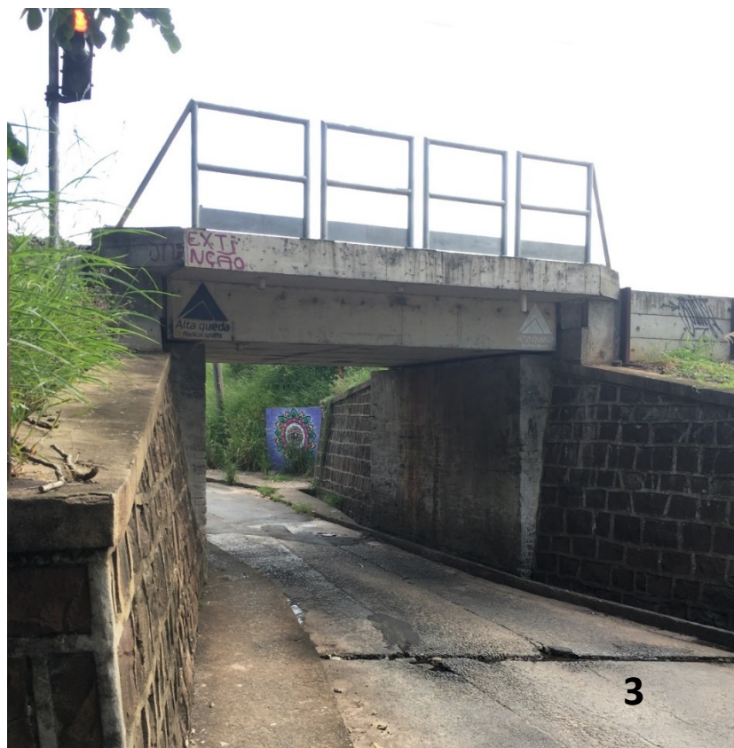
Figura 9 – Ponte ferroviária sobre a Avenida Araras, próxima à área do Ribeirão Tatu, Ponto 3 no Mapa 2
