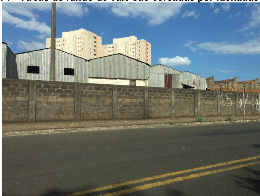
Figura 71 – Áreas de fundo de vale são cercadas por fachadas inativas
