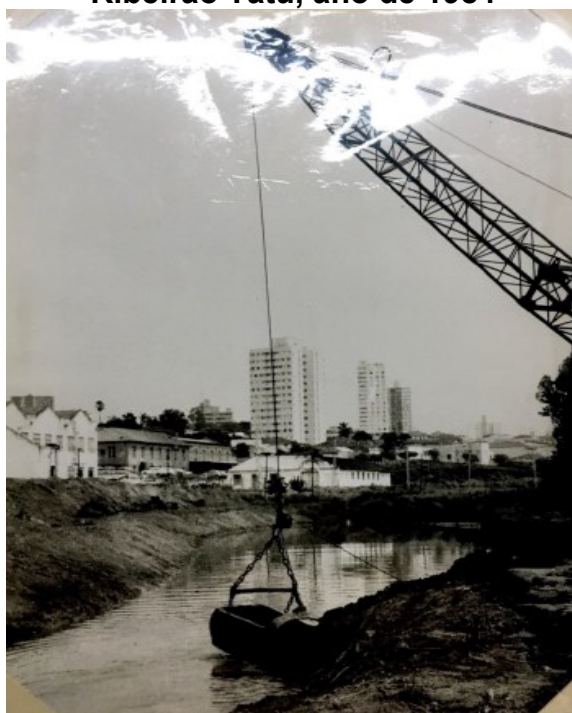
Figura 56 – Maquinário intervindo no processo de assoreamento do Ribeirão Tatu, ano de 1984
