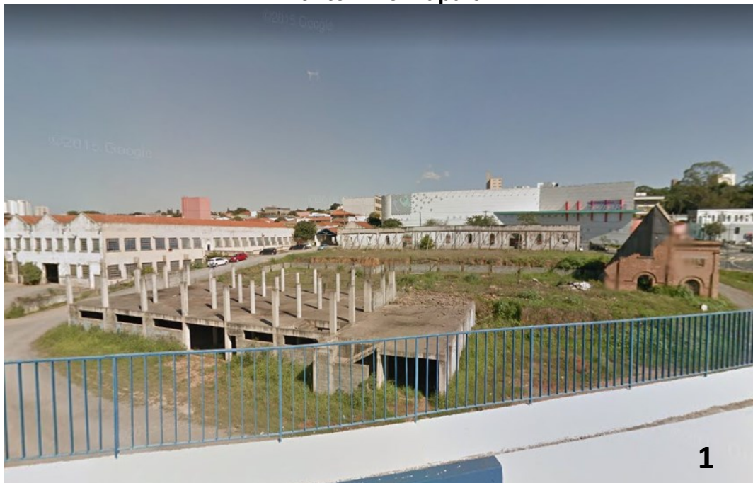
Figura 31 – Ruínas da antiga Machina São Paulo, vistas do pontilhão, Ponto 1 no Mapa 3
