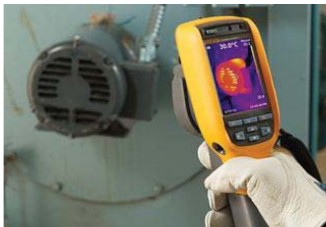
Figura 13 – Exemplo de aplicação do termovisor em equipamentos térmicos
