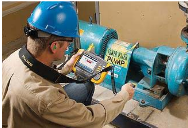
Figura 18 – Aplicação do medidor 810 em bomba de água
