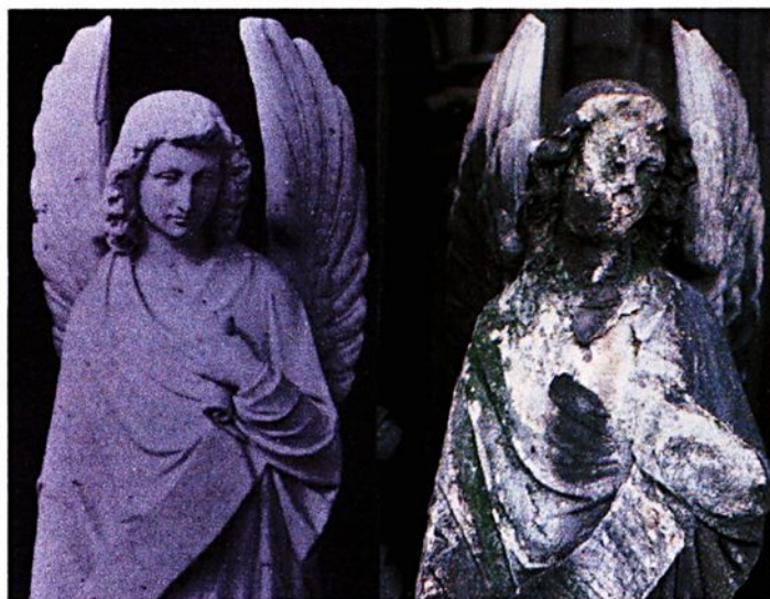
Figura 65: Escultura, em calcário, da Catedral de Colônia, Alemanha, em foto de 1880 (à esquerda) e desfigurada pelo efeito da chuva ácida, em foto da década de 1990 (à direita).
