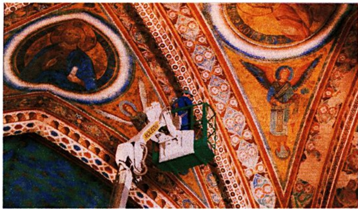
Figura 67: Finalização dos trabalhos de restauração no teto da Basílica de Assis.
