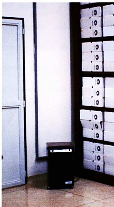
Figura 15: Desumidificador em uma sala do Arquivo Central da UNICAMP.
