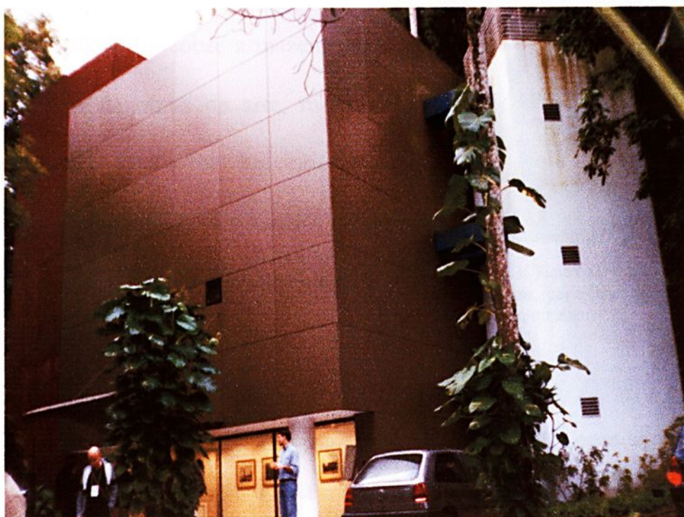
Figura 22: O edifício da reserva técnica fotográfica do Instituto Moreira Salles do Rio de Janeiro. Nota-se o bloco central, que abriga o acervo, e os dois blocos laterais onde ficam as instalações hidráulica e elétrica.
