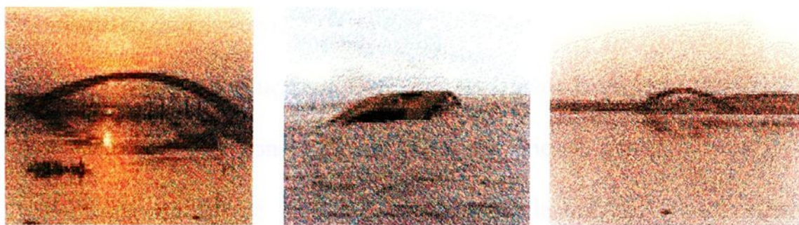
Figura 18 - Etapas da submersão da ponte Novo Oriente.
