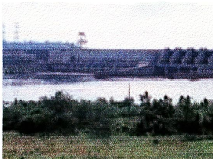
Figura 4- Vista a jusante da Usina Hidrelétrica de Três Irmãos
