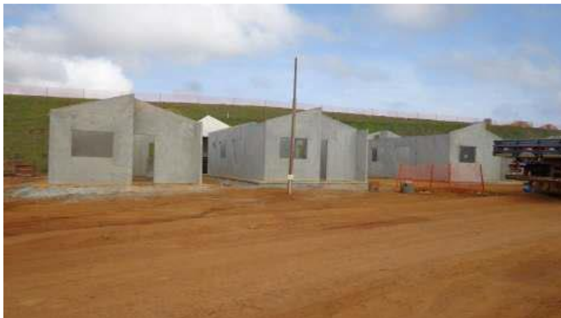
Figura 25 - Construção das casas do reassentamento urbano
