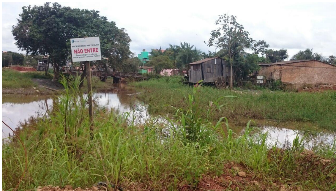
Figura 29 - Detalhe da placa da Norte Energia proibindo acesso às casas - Altamira
