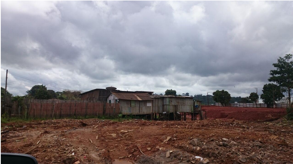
Figura 28 - Demolição das casas do Bairro Invasão dos Padres Altamira
