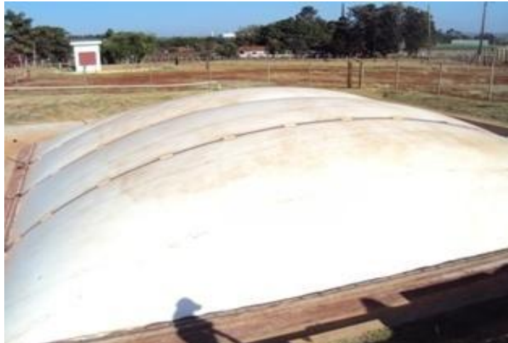
Figura 3. Câmara de fermentação com cobertura superior de lona de PVC para retenção do biogás.
