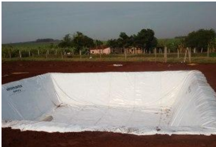
Figura 2. Câmara de fermentação subterrânea revestida com material impermeabilizante.
