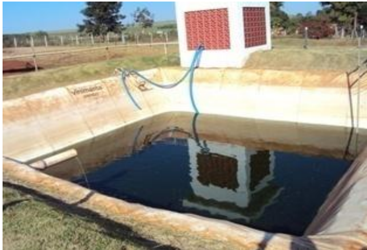
Figura 4. Lagoa de estabilização.
