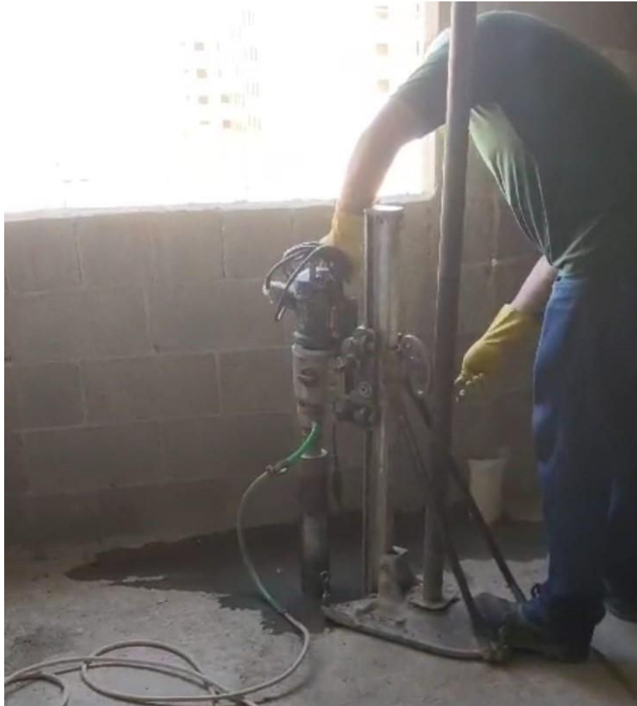
Figura 6: operador da ABCP realizando extração de testemunho de laje
