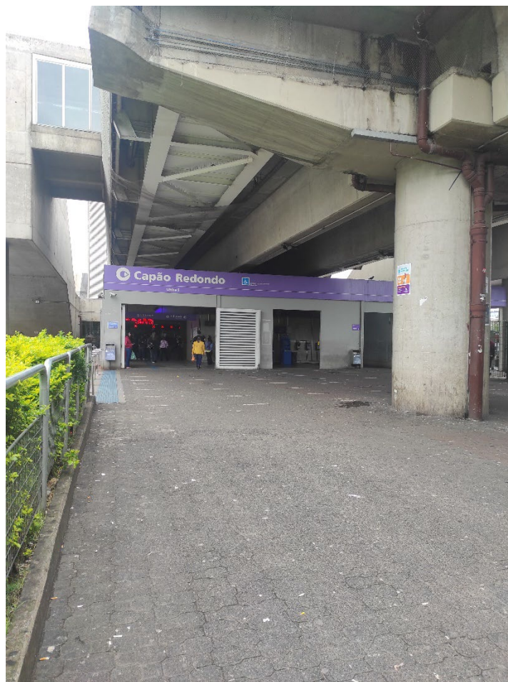
Foto 8 - Entrada da estação Capão Redondo (Silva, 2024)
