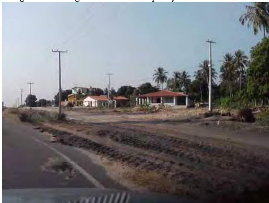
Figura 26 – Fotografia da Obra de duplicação da Rodovia CE 040
