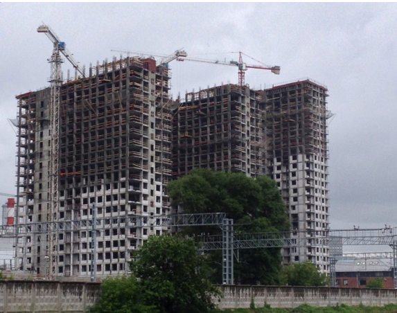
33 | Construções em andamento nos arredores da fábrica AMO ZIL , de Lucas Gervilla. Moscou, Rússia, 2017. Acervo Pessoal.
