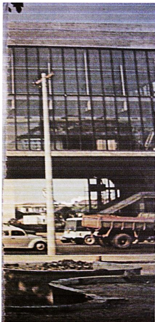
MASP em fase de construção na av. Paulista (In: Revista Manchete, 1968)
