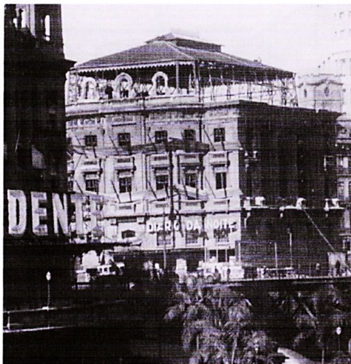
Detalhe mostrando edifício dos Diários Associados em reforma durante 1938 na região central de São Paulo (TOLEDO, 1980, p. 145).
