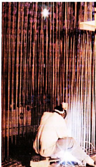
Funcionário soldando as hastes de metal no chão (Denise Andrade)
