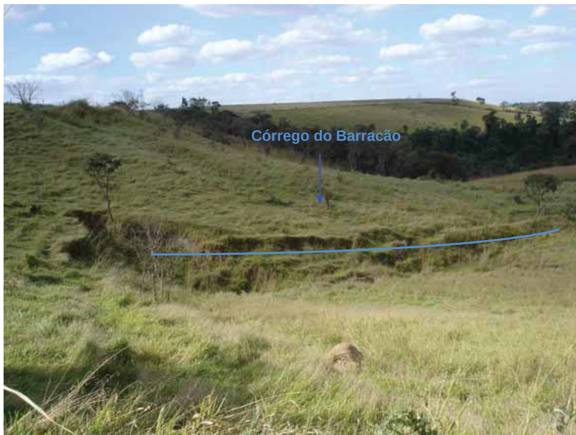
Foto 05 - Foto próxima ao local de amostragem número 16 (Córrego do Barracão), mostrando um processo de abatimento da superfície, gerando um desnível de aproximadamente 5m.
