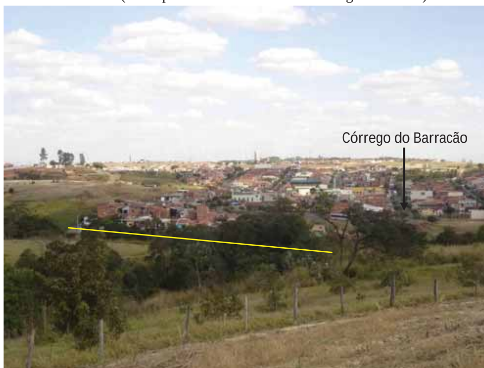
Foto 04 - Bairro com casas construídas em locais de área de risco próximas ao Córrego do Barracão (corresponde ao local assinalado na figura anterior).
