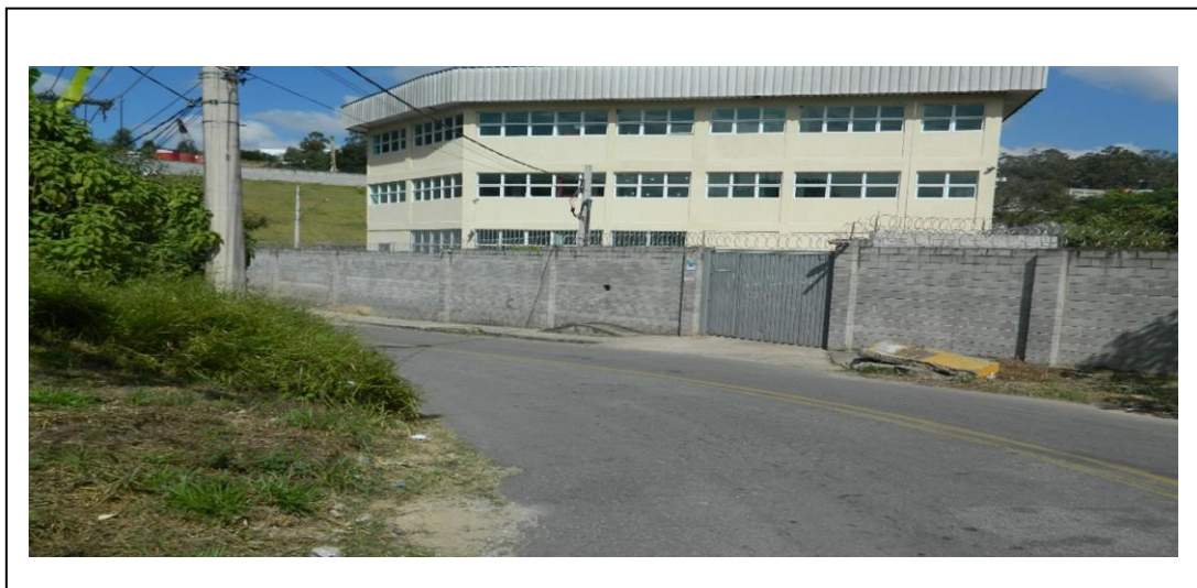
Figura 9. Empresa construída sobre planície fluvial do Rio das Pedras.
