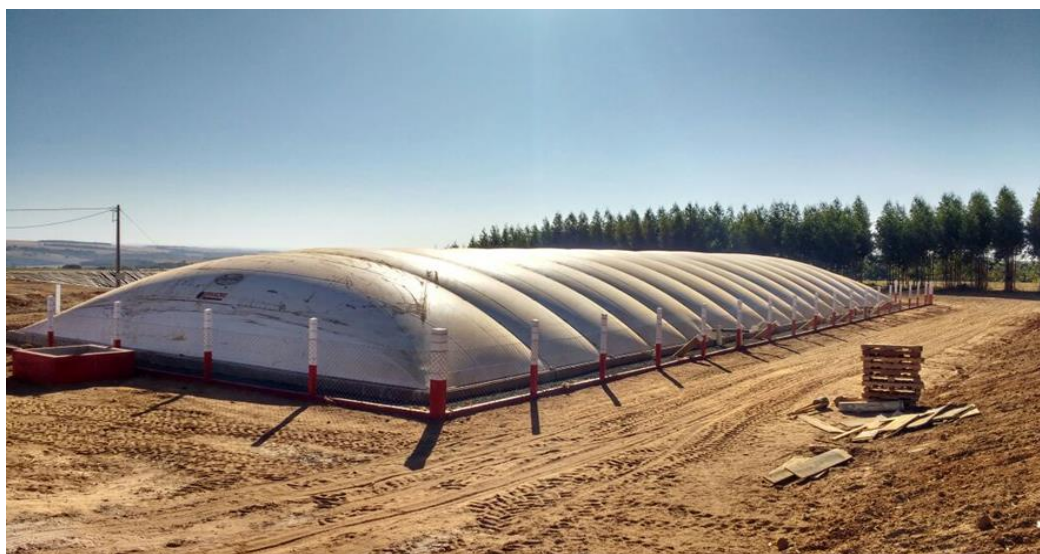
Figura 11. Biodigestor instalado no município de Rio Verde (GO).
