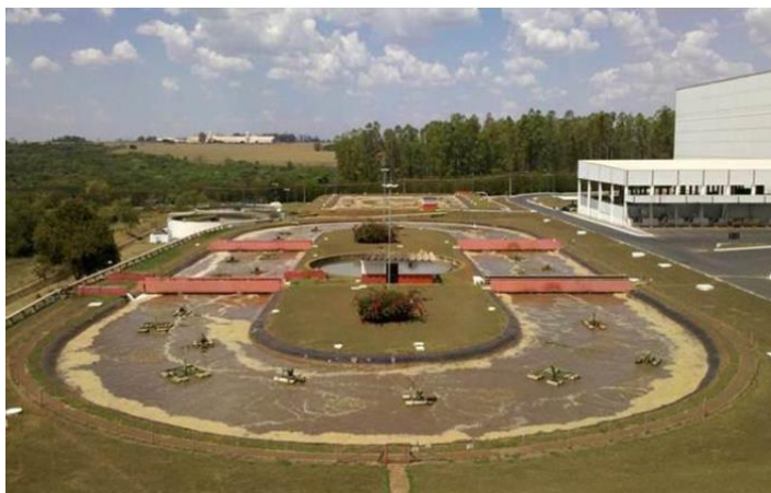
Figura 16. Valo de oxidação - Sistema de lodo ativado.
