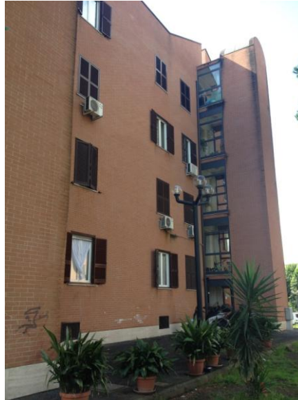
Figura 38 - Detalhe do bloco de elevador inserido com estrutura independente do corpo do edifício no Conjunto Residencial San Basilio
