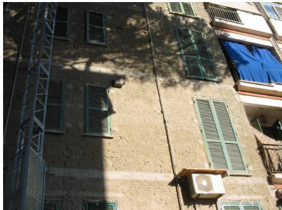
Figura 40 - Antes da aplicação do revestimento externo do edifício no Conjunto Residencial San Basilio
