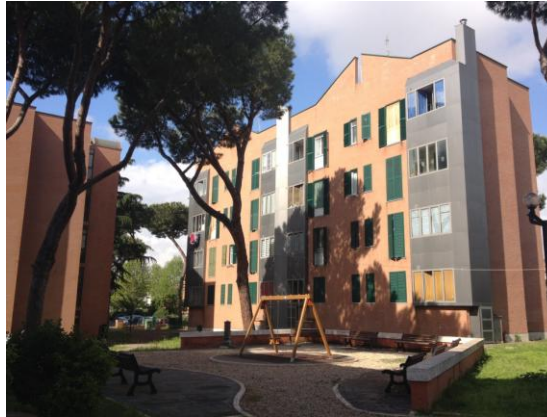
Figura 32 - Fechamento das varandas com placas de alumínio, após reconfiguração do Conjunto Residencial San Basilio
