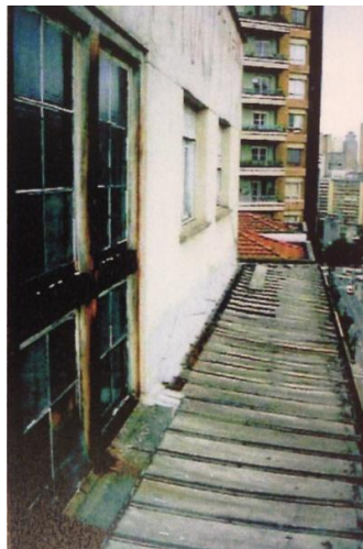
Figura 58 - 13º andar, antes da reabilitação
