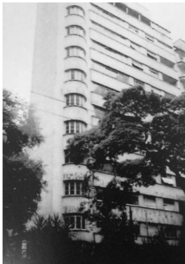
Figura 50 - Fachada do Edifício Maria Paula
