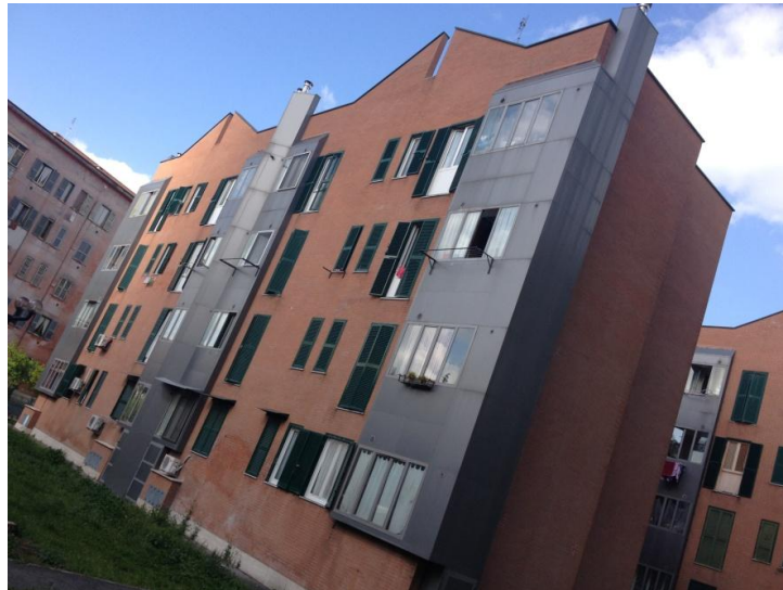
Figura 39 - Detalhe das placas metálicas usadas para fechamento das varandas no Conjunto Residencial San Basilio
