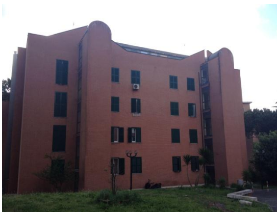
Figura 30 - Nova configuração tipológica dos edifícios após reconfiguração do Conjunto Residencial San Basilio – Fachada Leste
