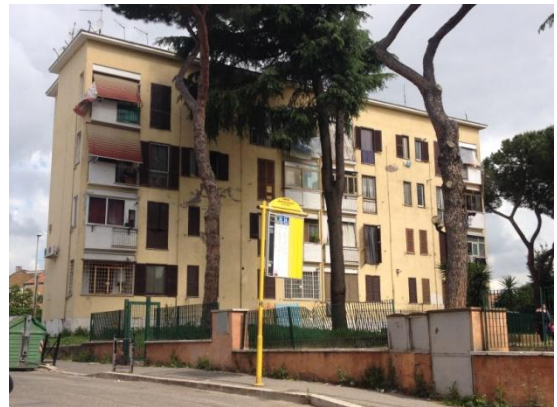
Figura 34 - Detalhe do edifício original da década de 50 que será demolido.
