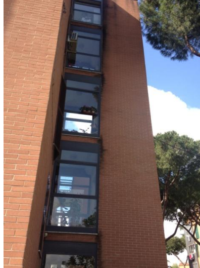
Figura 44 - Detalhe dos materiais do bloco de elevadores do Conjunto Residencial
