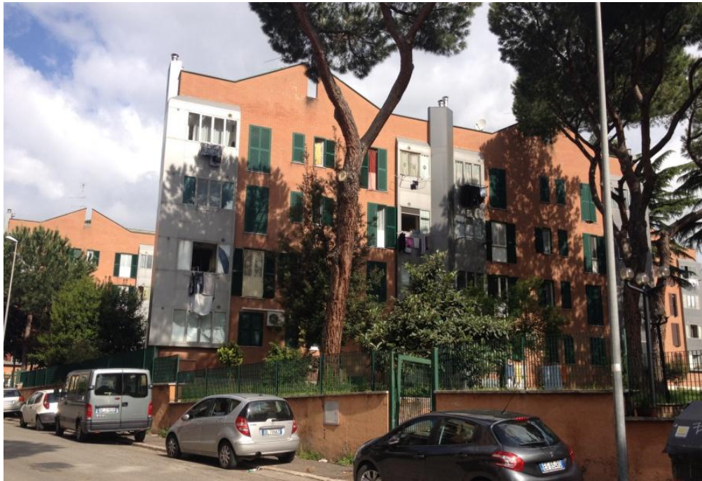
Figura 37 - Gradil e acessos do Conjunto Residencial San Basilio, promovendo permeabilidade visual entre os espaços público/privado
