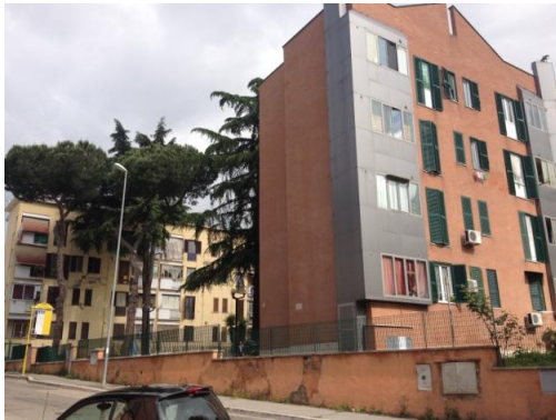
Figura 33 - Edifício reabilitado em primeiro plano e o edifício original que será demolido ao fundo.
