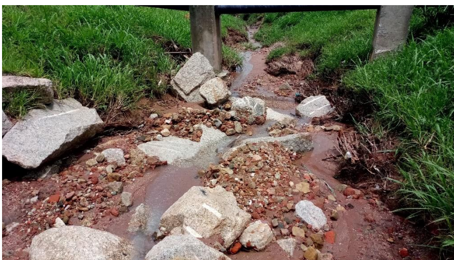
Figura 10 - Assoreamento do Córrego Piratininga causado por erosão do solo.
