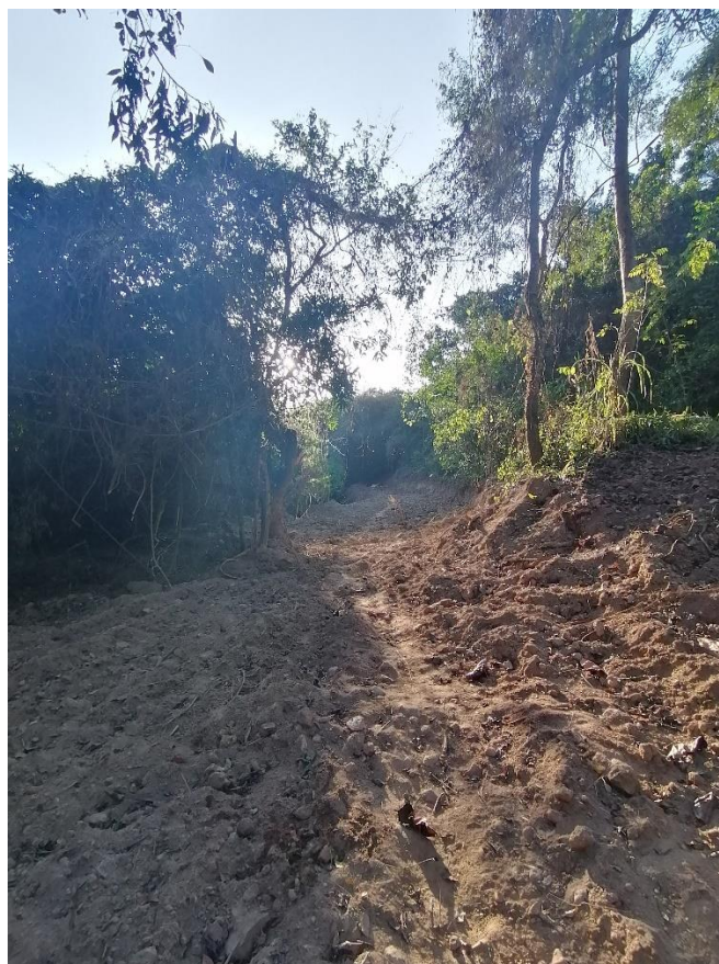
Figura 15 - Área de remoção de vegetação para acessibilidade de manutenção na rede coletora de esgoto.
