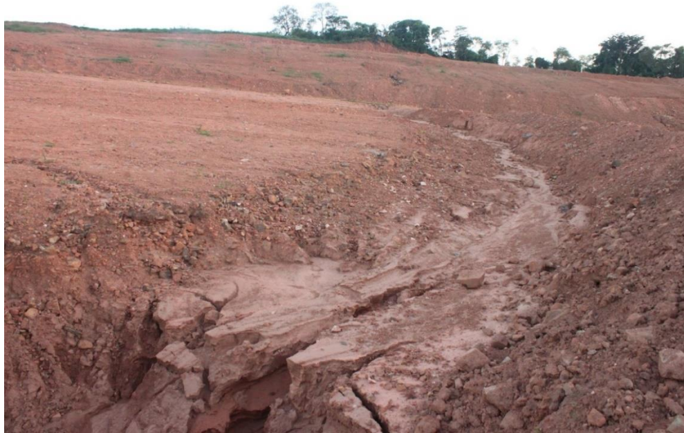
Figura 7 - Vista ampla da terraplanagem do Condomínio Residencial Pampulha.
