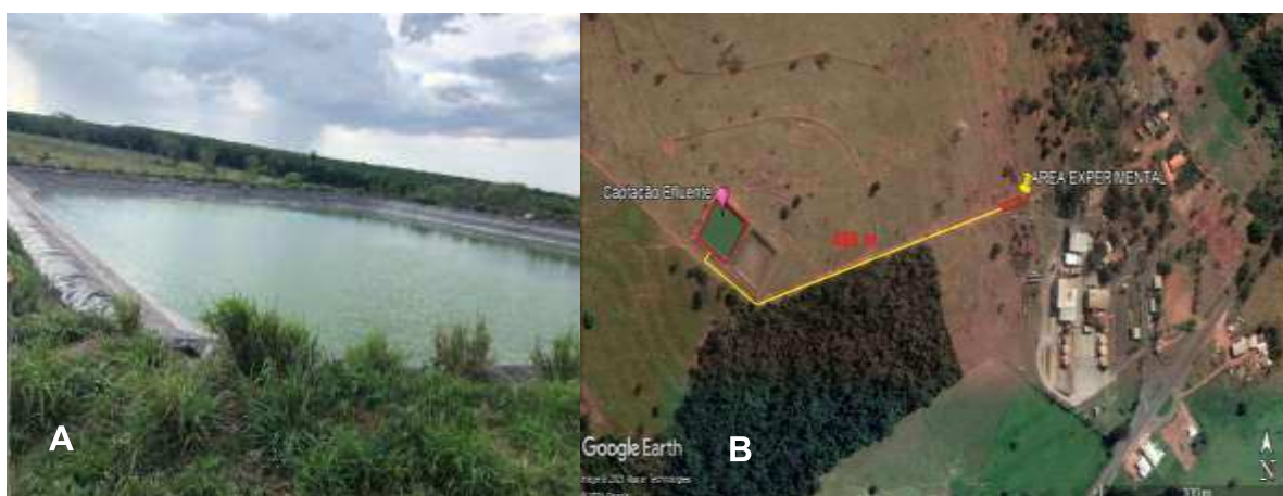
Figura 7. Vista da lagoa facultativa (A) e o caminho do efluente para fertirrigação (B).
