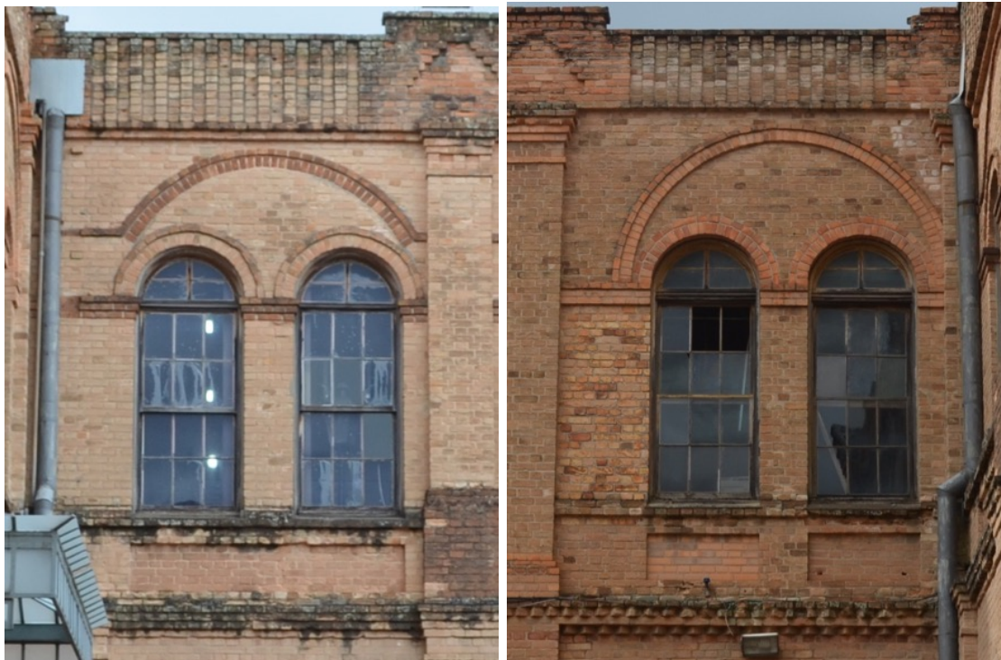
Figuras 47 e 48 - Área externa da seção central onde se podem visualizar algumas diferenças nos ornatos das elevações laterais e frontais, respectivamente.
