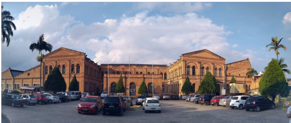
Figura 24 - Panorama da fachada principal das oficinas de Jundiaí.
