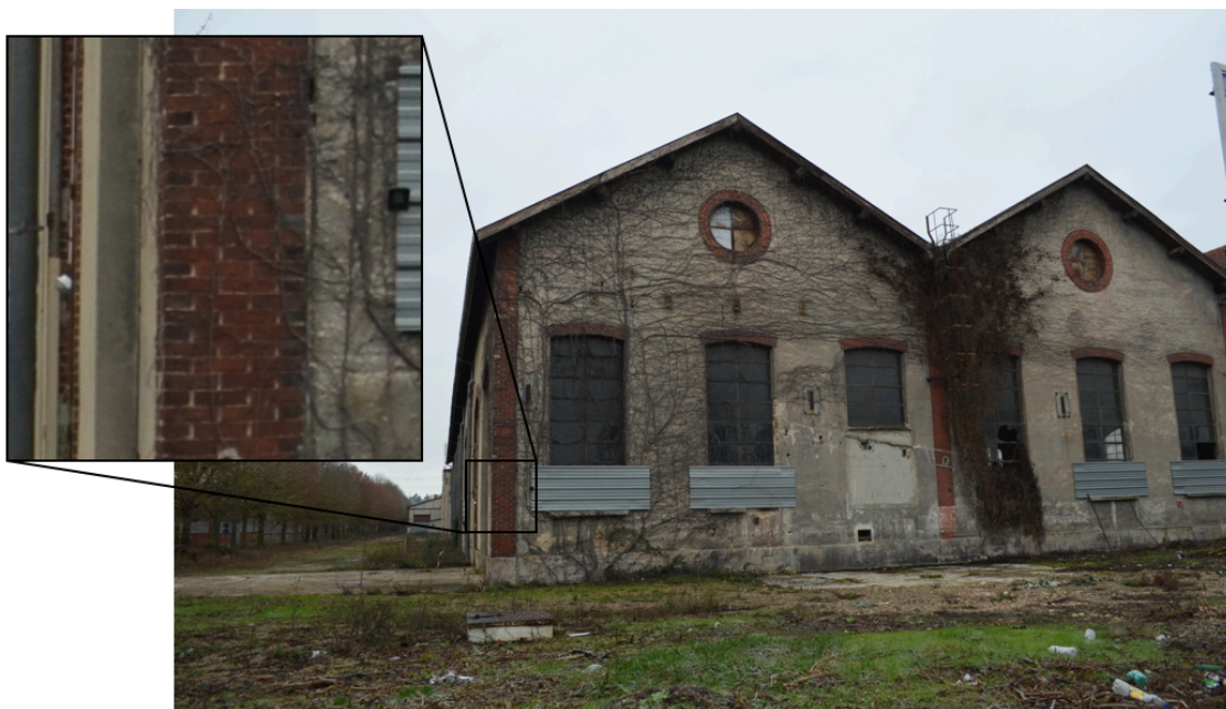
Figura 58 - Oficinas de Epernay. Nota-se a parede rebocada e sistema de aparelhagem regular no cunhal (no detalhe), o uso do óculo e sutis ornamentações nas aberturas.
