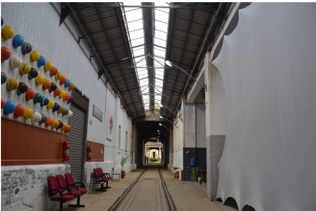
Figura 32 - Vista interna da seção Norte fazendo conexão com a seção Sul. Hoje destinada para outros fins, a área ainda se beneficia da iluminação e ventilação do lanternim.
