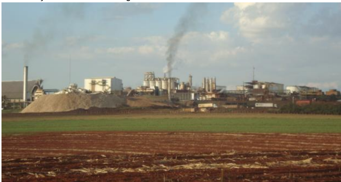
Foto 2.3 - Vista panorâmica da Central Energética Vale do Sapucaí e plantação de cana-de-açúcar à frente em estágio inicial.
