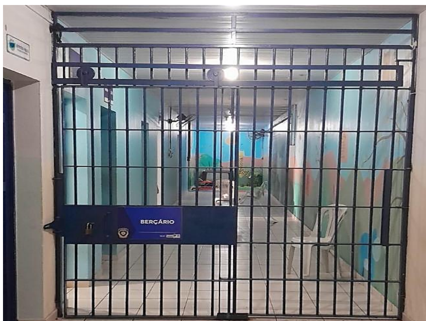
Figura 12 – Entrada do berçário
