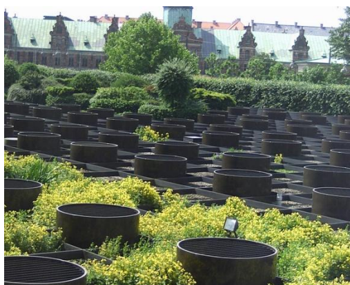
Figura 12 - Telhado verde intensivo. Fonte: Atitude Sustentável (2013)
