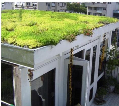
Figura 11 - Telhado verde extensivo. Fonte: Ecotelhado (2013)
