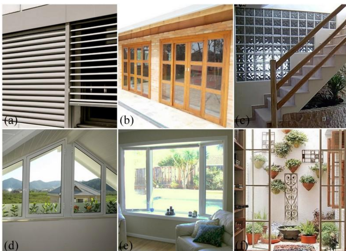
Figura 7 - (a) Brise. (b) Porta-balcão. (c) Tijolo de vidro. (d) Janela de mansarda. (e) Bay windows. (f) Jardins internos.
