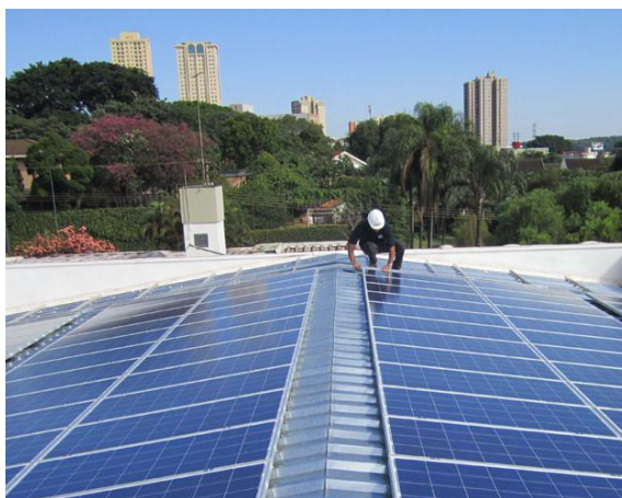
Figura 3 - Sistema fotovoltaico sendo instalado.
