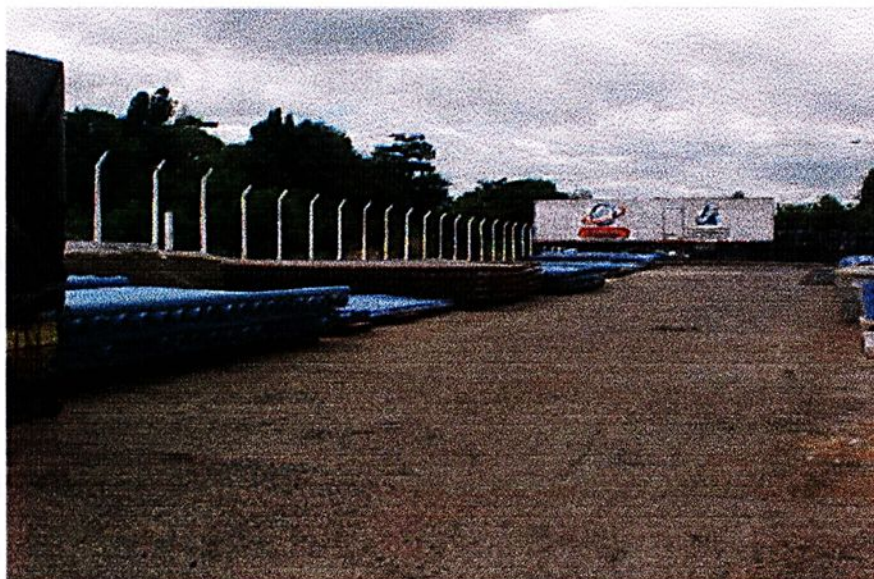
Figura 3.10 - Armazenamento de tubos PVC - ASPERBRAS
