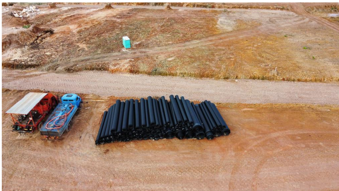
Figura 4: Armazenamento de tubos PEAD
