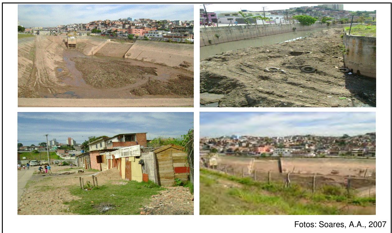
Fig.22 – Situação atual do reservatório do Parque Pinheiros.
