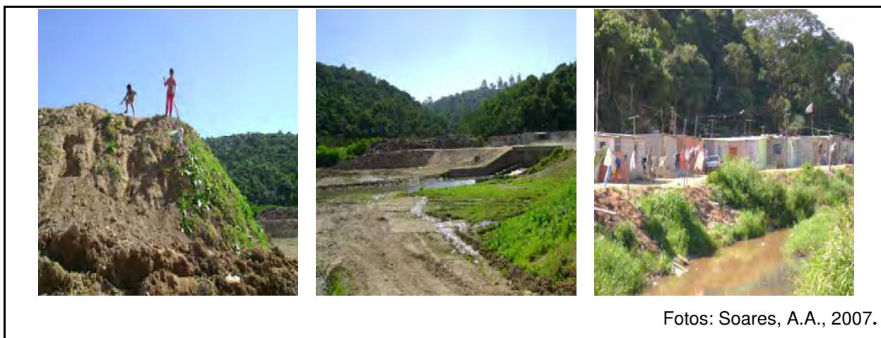
Fig.10 – Situação atual do reservatório Aricanduva II.
