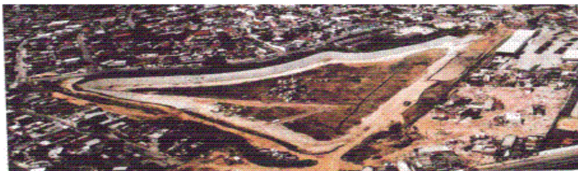
Foto c: Reservatório Guaraú durante as obras - (Canholi, 2005)
