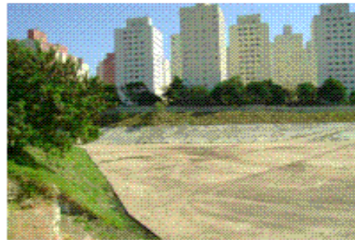
Foto b: Reservatório Rio das Pedras
