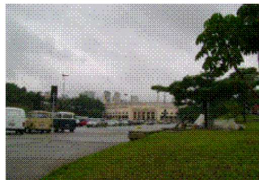
Foto C: Estacionamento sobre o reservatório
