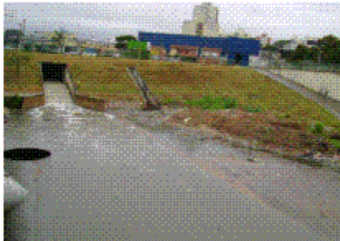
Foto a: Vertedor do reservatório
