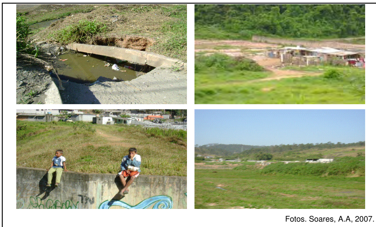
Fig.9 – Situação atual do reservatório Aricanduva I.
