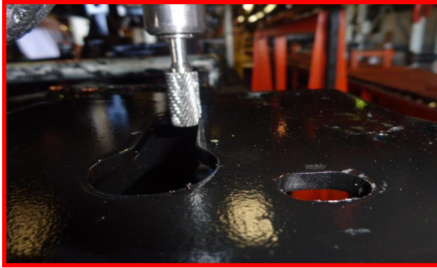
Figura 35 – Retrabalho nos furos oblongos
