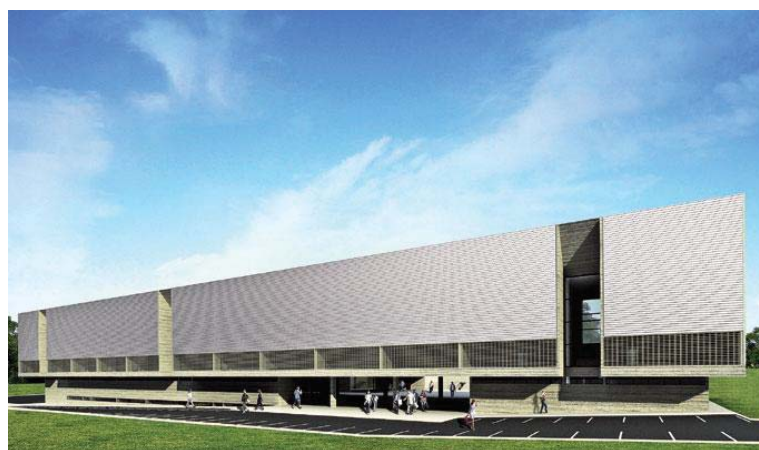
Figura 24 – Aberturas verticais no bloco de artes cênicas
