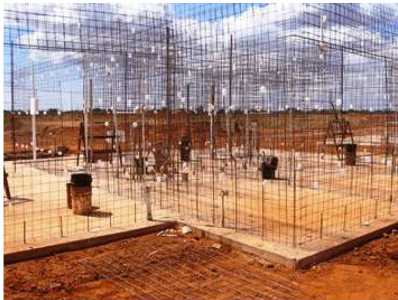
Figura 7. Disposição armaduras paredes de concreto.
