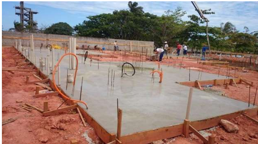
Figura 5. Radier concretado e tubulações emergentes.
