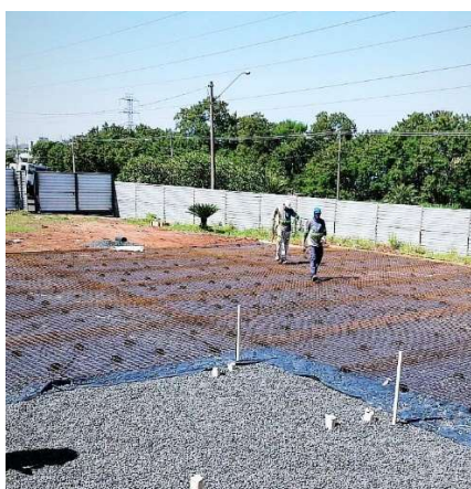
Figura 14. Fundação tipo radier.
