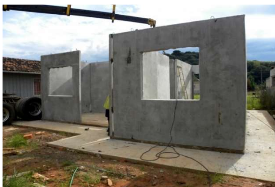
Figura 10. Montagem e fixação paredes pré fabricadas de concreto.
