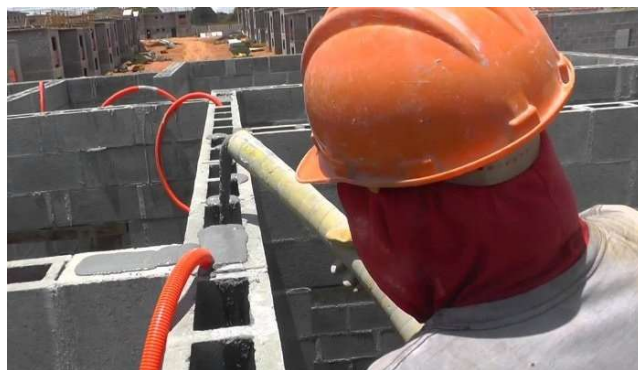
Figura 3. Grauteamento Alvenaria Estrutural.
