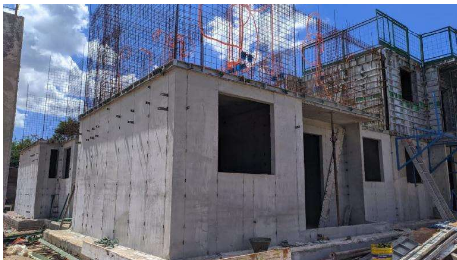
Figura 4. Sistema construtivo parede de concreto.
