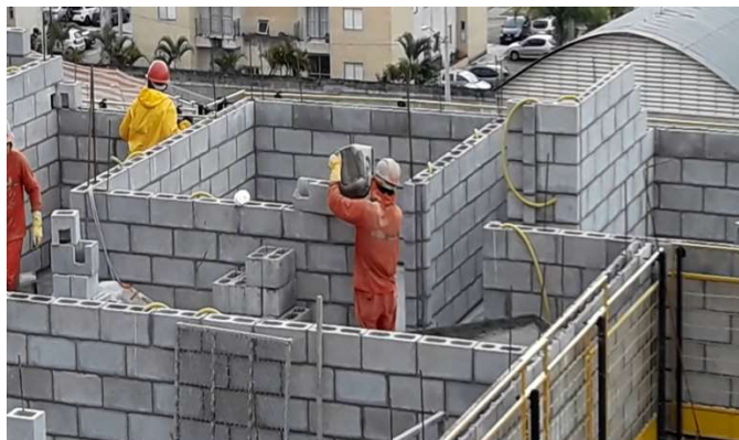
Figura 1. Representação obra alvenaria estrutural.
