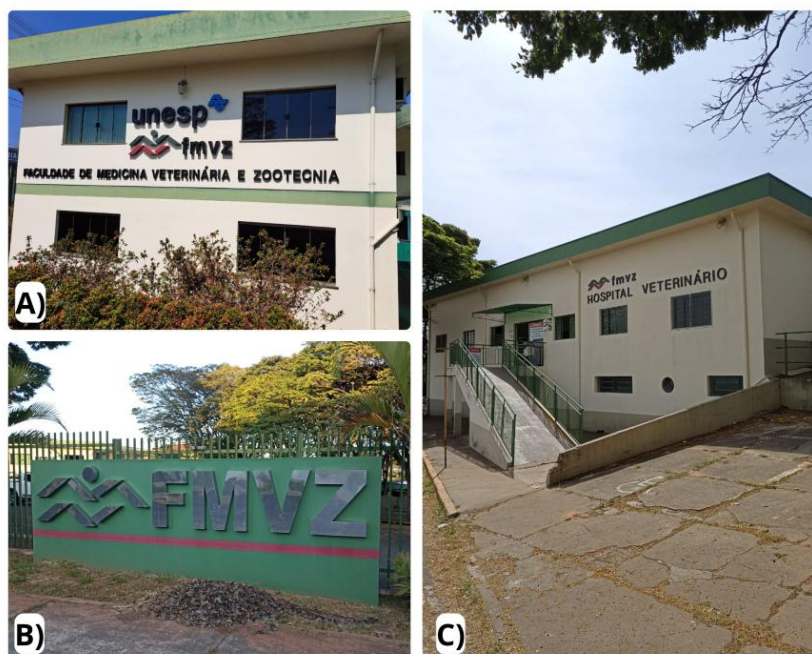
Figura 1. Estrutura do Hospital Veterinário da Faculdade de Medicina Veterinária e Zootecnia (FMVZ) – UNESP. A) Supervisão do Hospital Veterinário; B) Fachada do estacionamento do Hospital Veterinário; C) Recepção do Hospital Veterinário.
