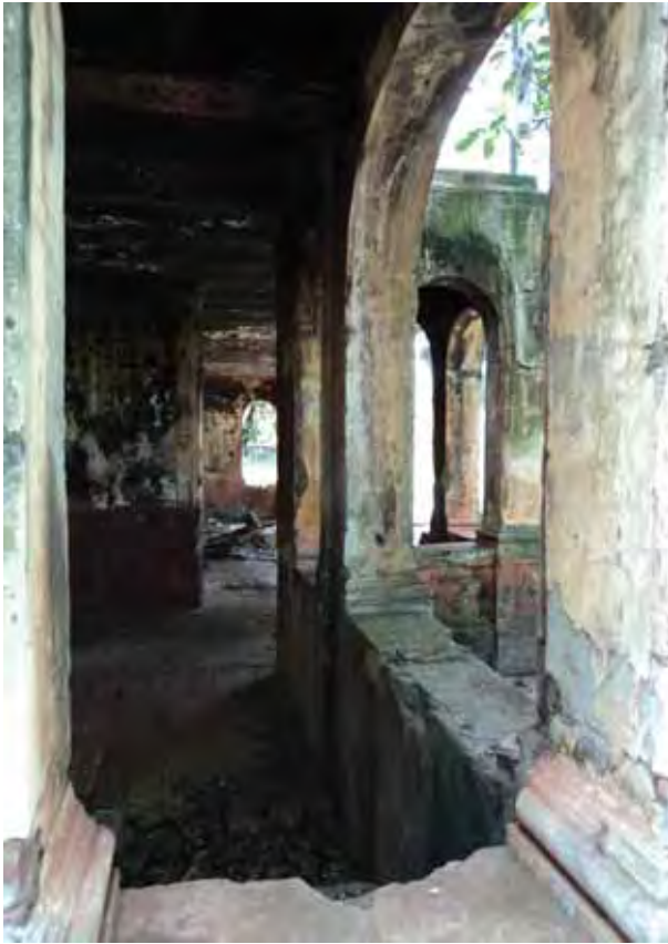
Foto 3: Parte interna do casarão.
