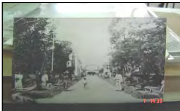
Figura 2: O Jardim Público visto pela Avenida 1 no início do século XX
