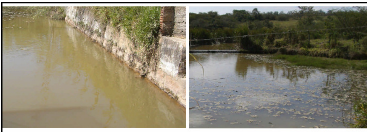
Figura 3.3.3: Reservatório da estação elevatória do Varejão localizada em uma estrada vicinal que cruza a rodovia SP-075 (Rod. Dep. Archimedes Lammoglia), próximo ao bairro Cidade Nova I, no período dos meses de estiagem.
