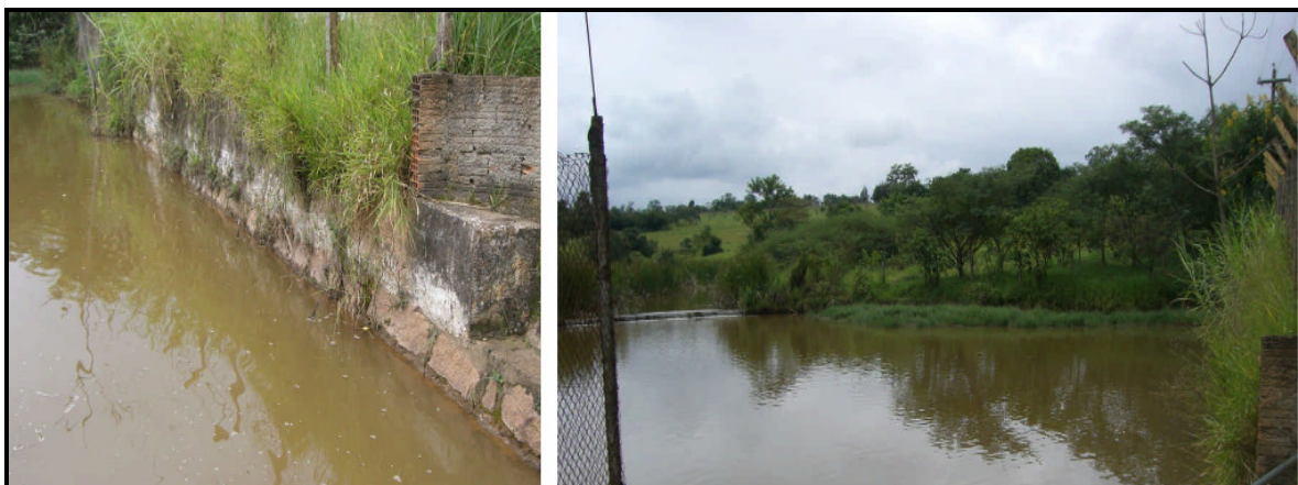
Figura 3.3.4: Reservatório da estação elevatória do Varejão localizada em uma estrada vicinal que cruza a rodovia SP 075 (Rod. Dep. Archimedes Lammoglia) próximo ao bairro Cidade Nova I, no período das chuvas. O nível da água não aparenta estar menor do que na época de estiagem. Foto: Maira Mitiyo Kunitake, 24/fevereiro2008.
