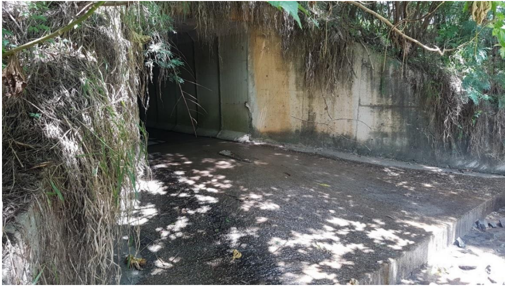
Figura 32: Degrau para diminuição de energia da água
