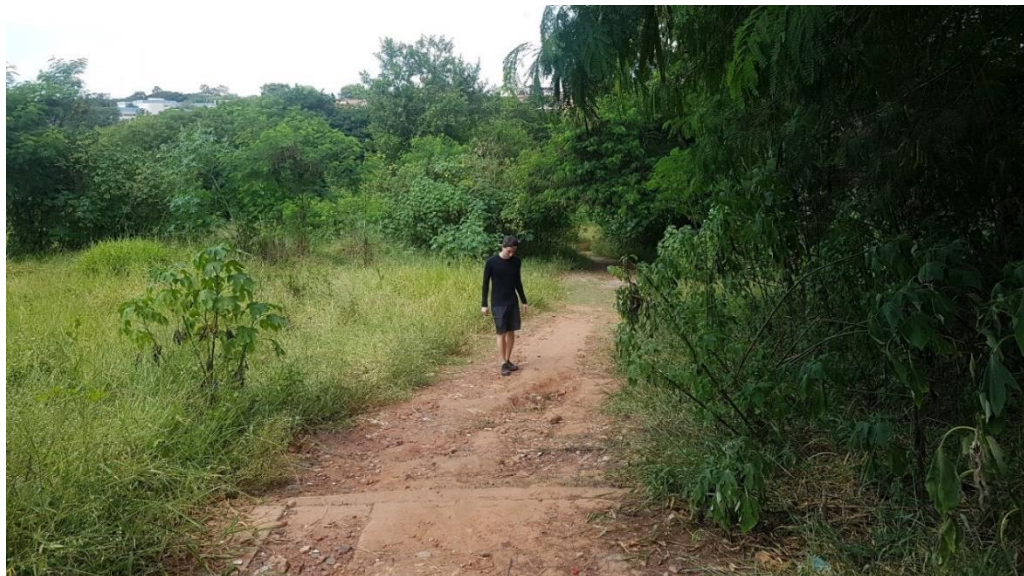
Figura 30: Sulcos erosivos no local
