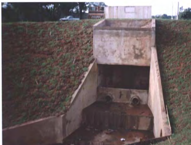
Parte da frente de onde se observa o lançamento de esgoto
