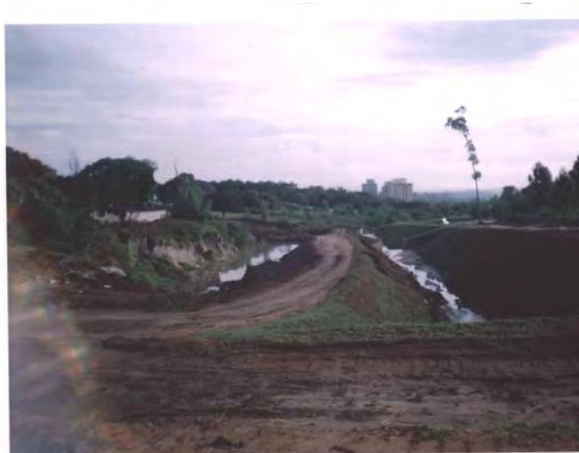
Desvio artificial do córrego da Água Comprida
