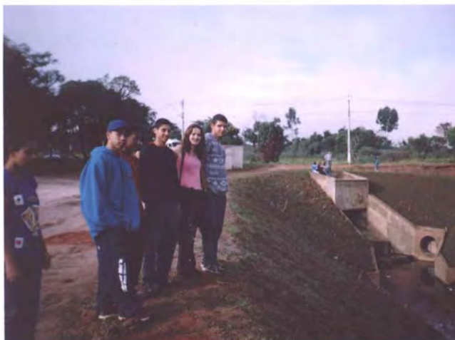
Esgoto do residencial no córrego da Água Comprida
