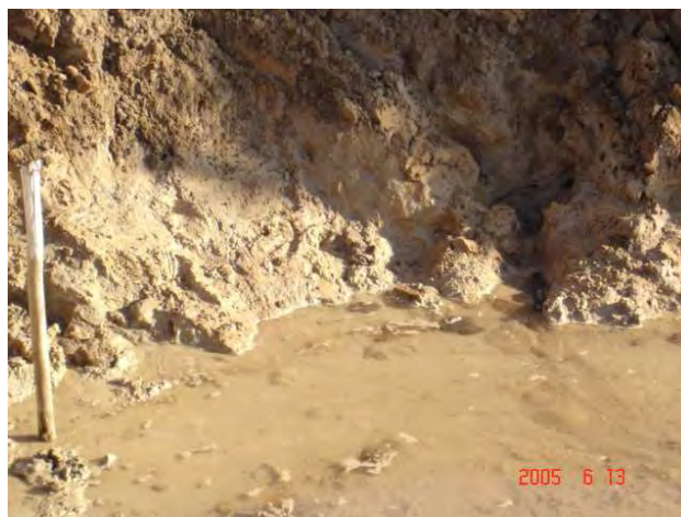
Escavação em busca de nascentes para abastecer o lago citado anteriormente
