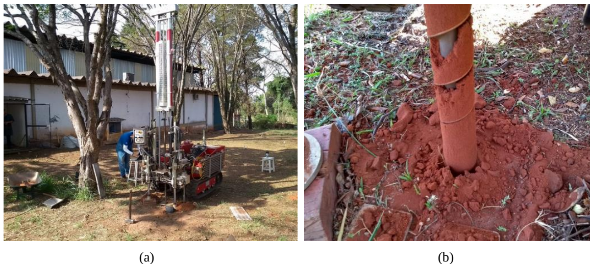
Figura 35: Execução do DMT em área com vegetação (a) e amostragem do solo com trado (b), campanha de fevereiro de 2021.
