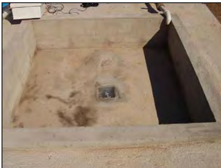
Figura 7 - Reator para desinfecção solar de águas residuárias domésticas (Fonte: SÁNCHEZ-ROMÁN et al., 2007).
