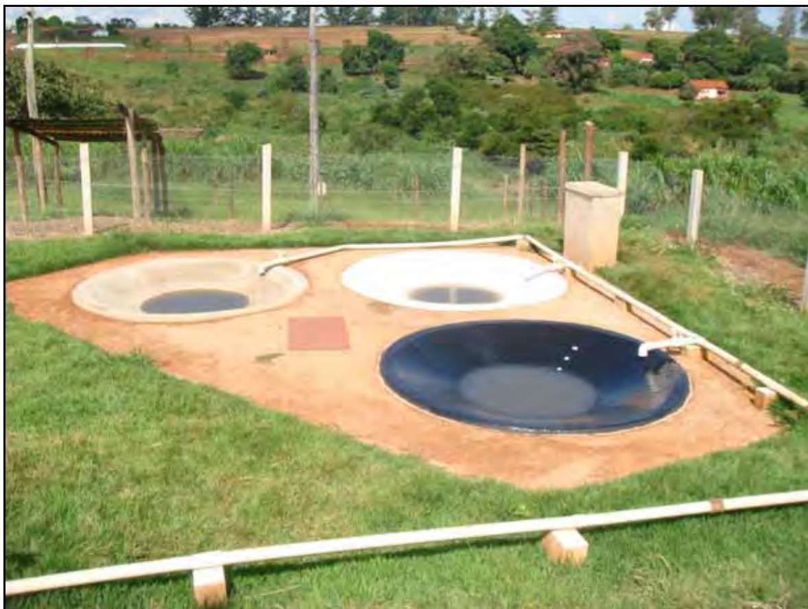
Figura 12 – Reatores de desinfecção solar com lâminas de 10 cm do efluente expostas à radiação solar.
