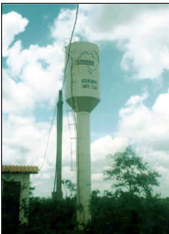
FOTO 3.6 – Caixa de abastecimento de água potável monitorada pela Fundação Nacional de Saúde (FUNASA) no Assentamento Santa Clara, no Município de Anaurilândia, MS (Dias, 12/2002)
