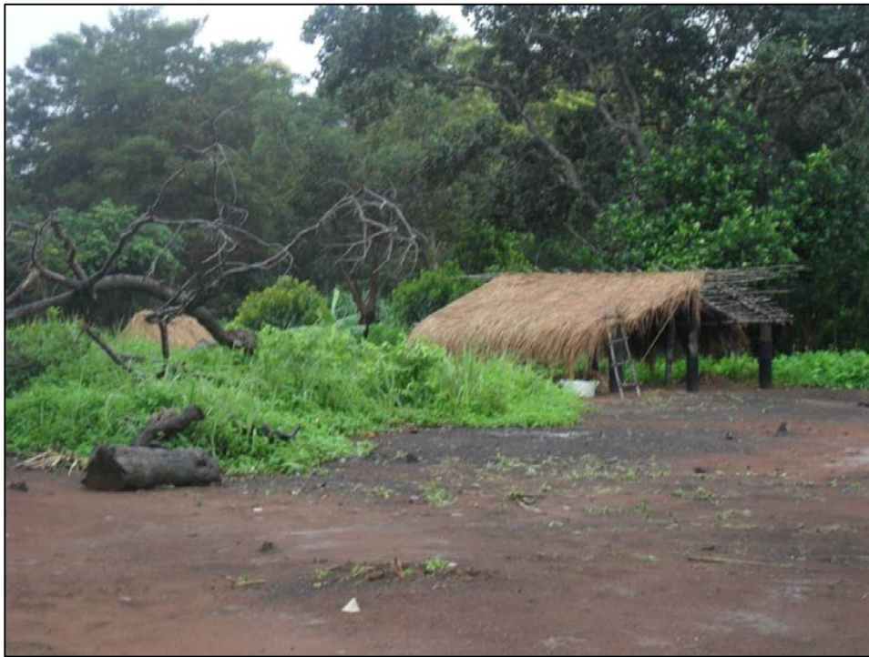
Figura 12: Cozinha externa em construção (POSTIGO, A. V. – janeiro/2012)
