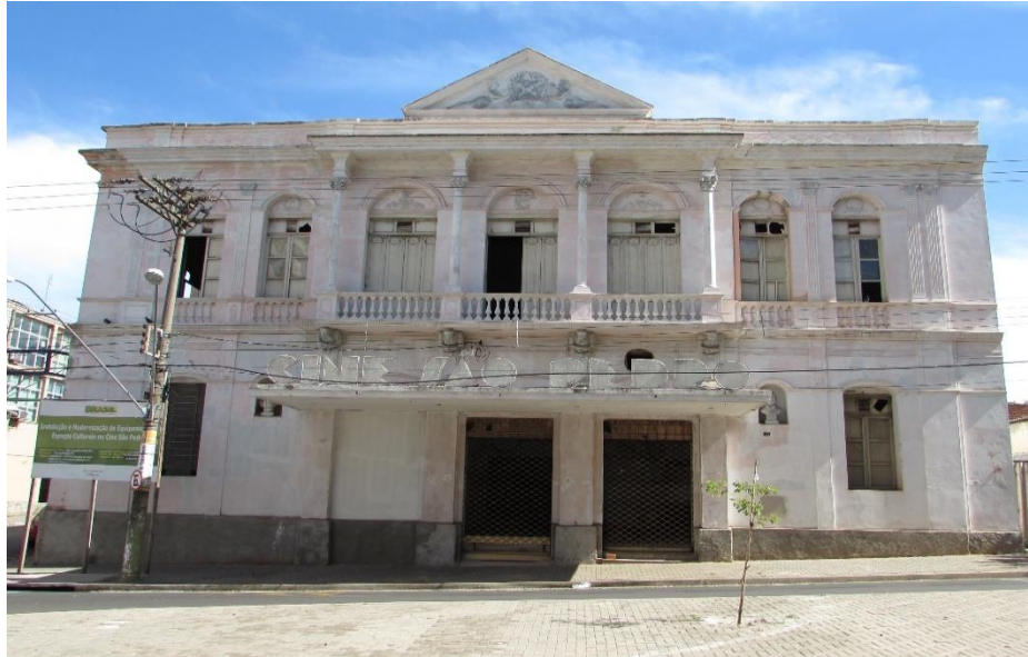
FOTO 1: Prédio do Cine São Pedro
