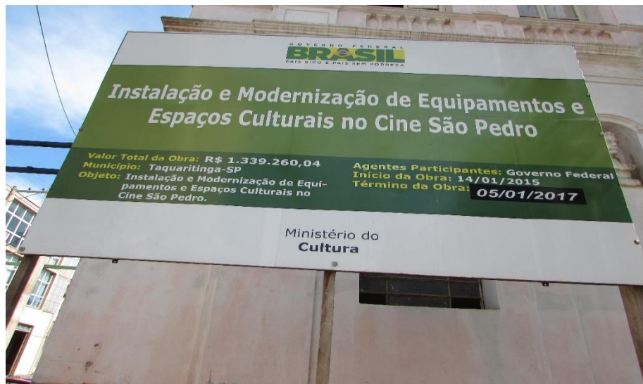
FOTO 2: Placa da obra do Cine São Pedro
