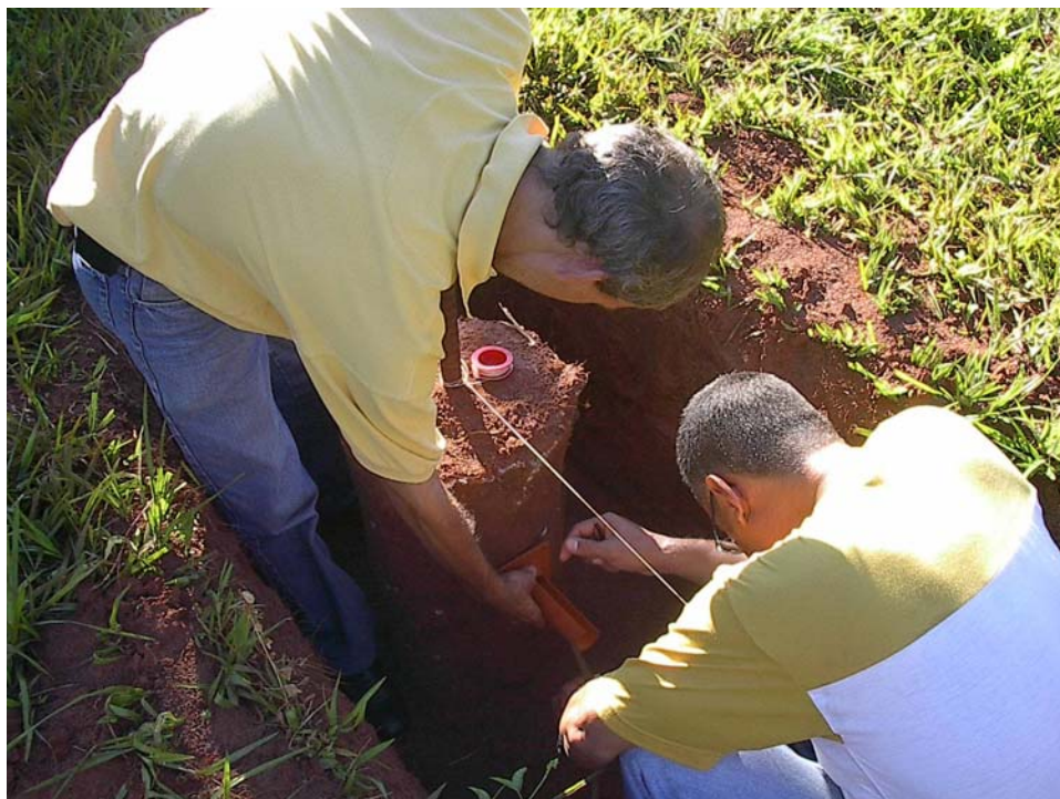
Foto 4.3. Nivelamento e alinhamento da bucha de aço.
