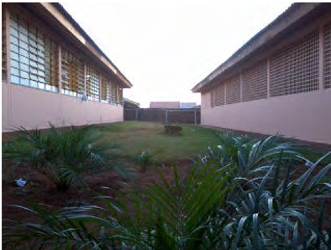
Figura 5 - Espaço entre blocos
