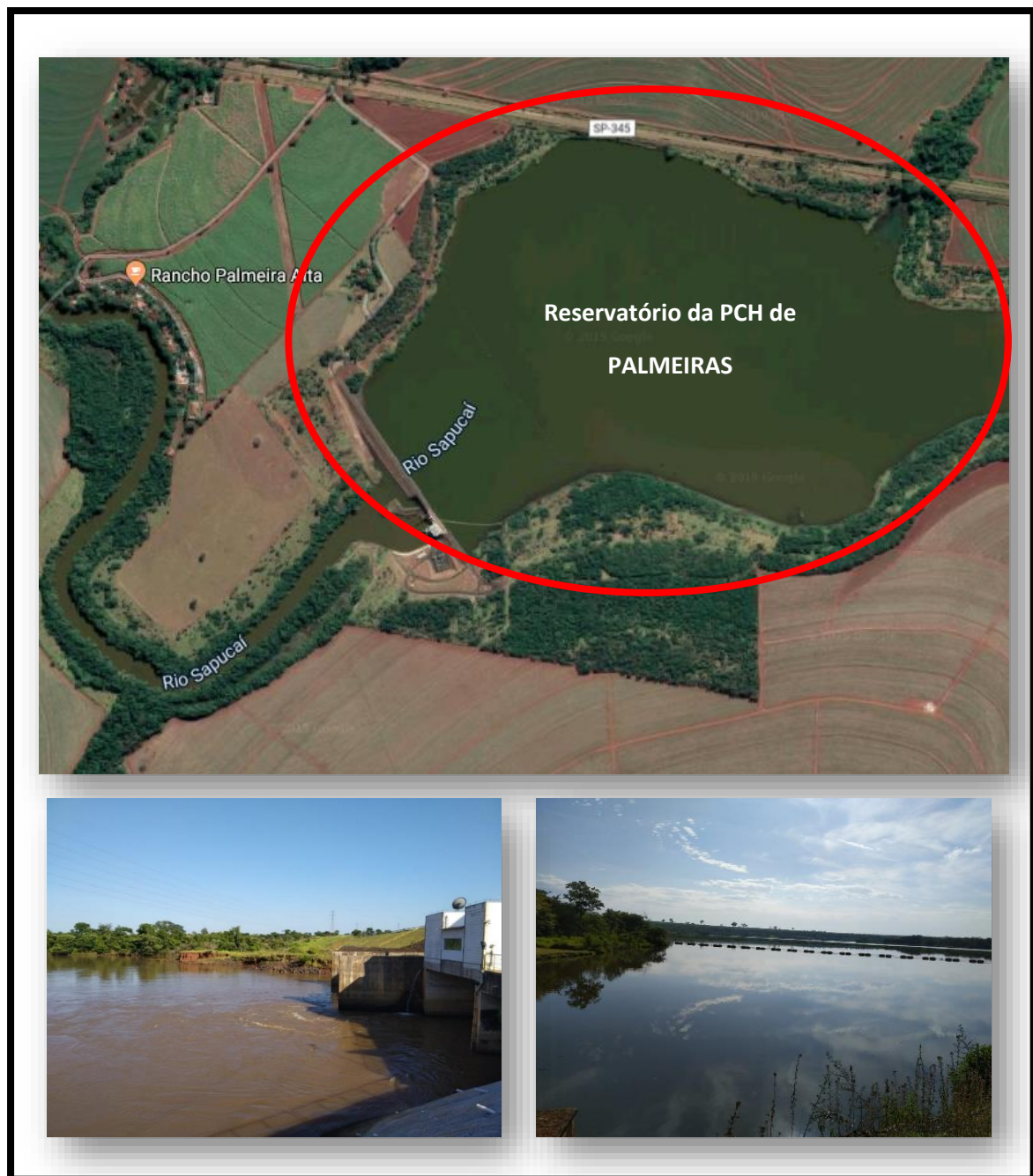
Figura 2. PCH de Palmeiras (reservatório evidenciado em vermelho).
