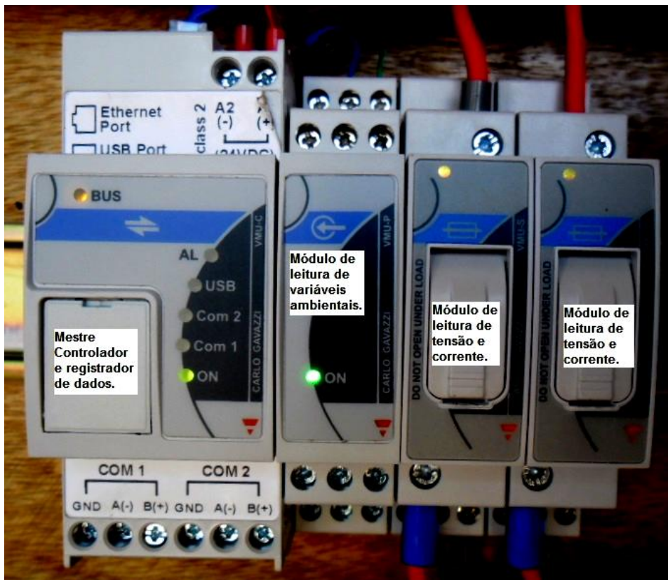
Figura 22 - Detalhe do equipamento VMU-M com as expansões
