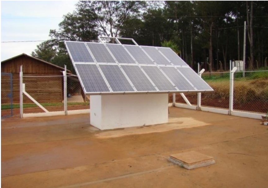
Figura 20- Suporte já instalado e a casa de equipamentos
