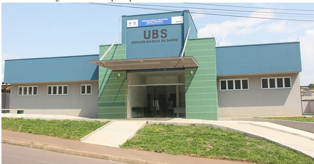
Figura 24: Fachada principal - UBS Porte I instalada em Colombo-PR.
