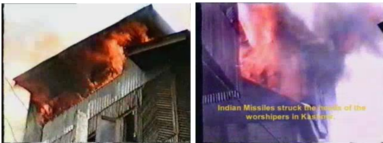
Figura 22: Prédios em chamas na Caxemira
