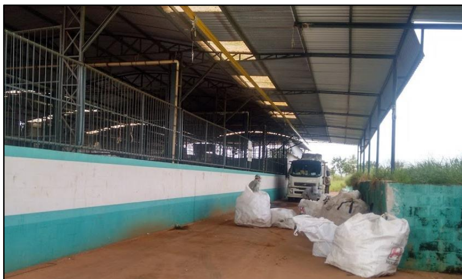
Figura 14 – Área de descarregamento e triagem das embalagens vazias de agrotóxicos da ARPEV, em Paraguaçu Paulista, São Paulo
