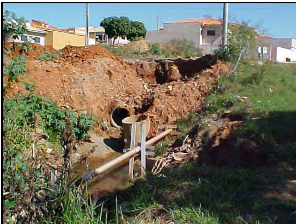
Figura 21: Tubulação das galerias pluviais associada a movimentação de terra degradam o O afluente do córrego da Colônia Mineira. Fonte: Pesquisa de Campo (2002). Autora: Adriana Olivia Alves.
