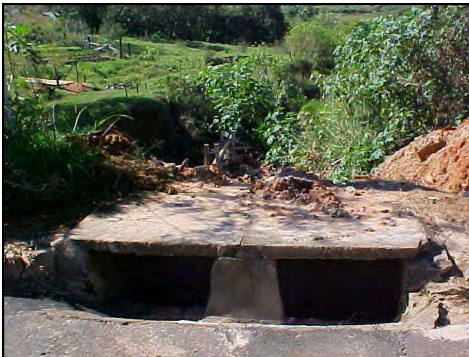
Figura 19: Boca de lobo no mesmo sentido do afluente do córrego da Colônia Mineira. Fonte: Pesquisa de Campo (2002). Autora: Adriana Olivia Alves.
