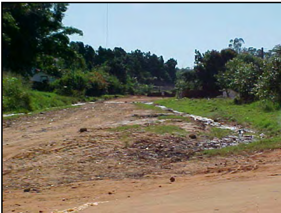
Figura 15: Trecho do córrego canalizado na Vila Geni, uma das áreas com maiores Ambientais: enchentes sazonais, esgoto à céu aberto, carência de áreas de lazer e equipamentos institucionais (creche, posto de saúde, escolas), apontado por esta pesquisa com péssima qualidade de vida bairro. Fonte: Pesquisa de Campo (2002). Autora: Adriana Olivia Alves.
