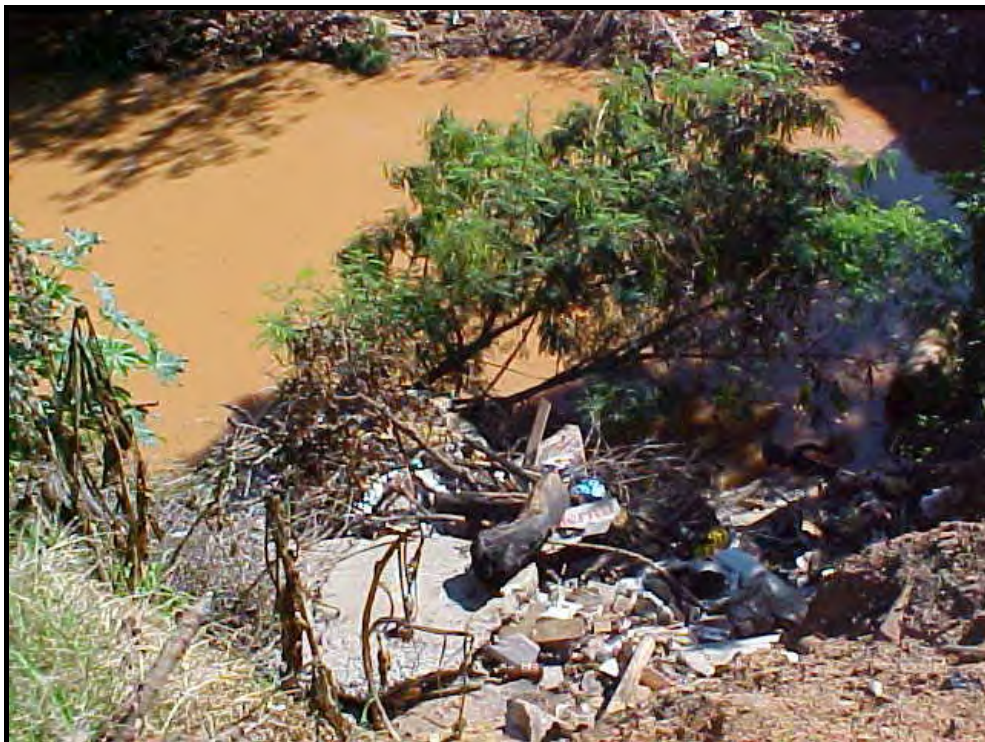
Figura 23: Assoreamento e deposição de entulho no leito principal do córrego na Vila Geni. Fonte: Pesquisa de Campo (2002). Autora: Adriana Olivia Alves.
