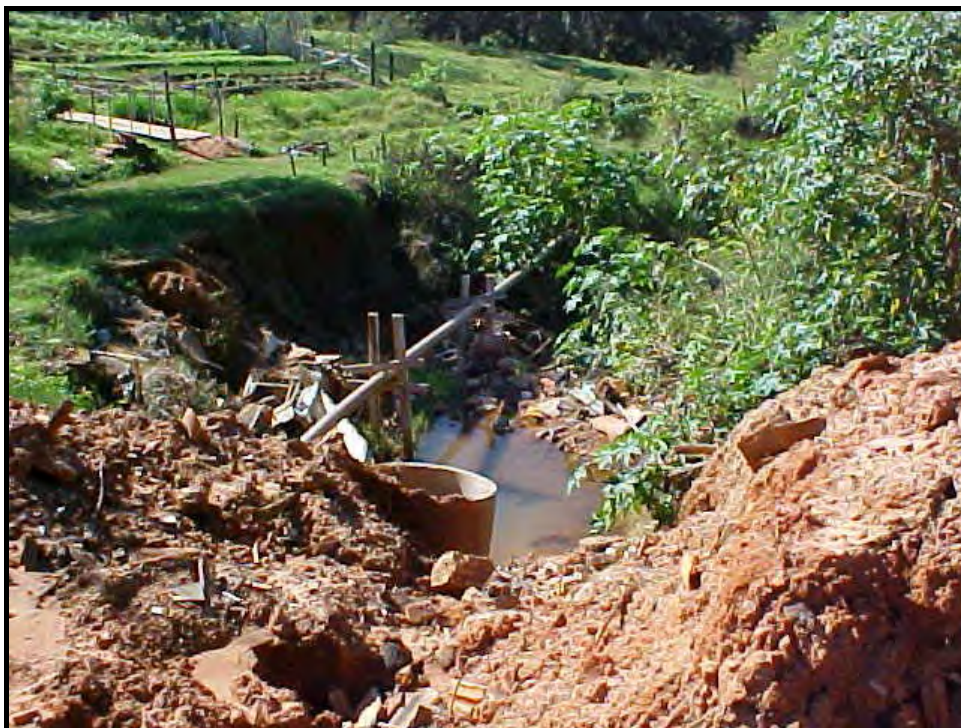
Figura 18: Voçorocamento do afluente do córrego da Colônia Mineira, intensificada pelas tubulações de águas pluviais. Fonte: Pesquisa de campo (2002). Autora: Adriana Olivia Alves.
