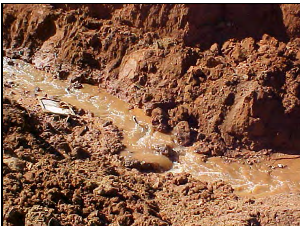
Figura 20: Assoreamento do córrego da Colônia Mineira com carga em suspensão provocado por obra de substituição da canalização fechada. Fonte: Pesquisa de Campo (2002). Autora: Adriana Olivia Alves.
