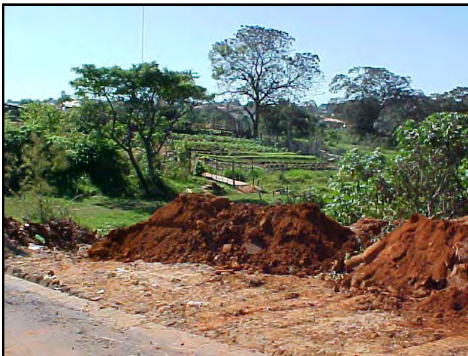
Figura 14: Movimentação de terra localizado no CDHU Sítio São Pedro nas proximidades de um afluente do córrego da Colônia Mineira. Fonte: Pesquisa de Campo (2002). Autora: Adriana Olivia Alves.
