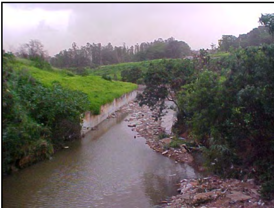
Figura 02: Canalização aberta de concreto entre a Vila Geni e a foz do córrego da Colônia Mineira: intenso impacto assoreamento e presença de entulhos. Fonte: Pesquisa de Campo (2002). Autora: Adriana Olivia Alves.
