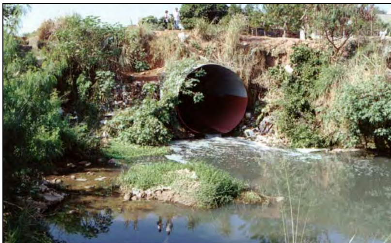
Figura 12: Trecho do córrego da Colônia Mineira onde o canal de drenagem está canalizado. Neste período havia o afloramento da vegetação. Fonte: Pesquisa de Campo (2000). Autor: Adriano Rodrigues de Oliveira.
