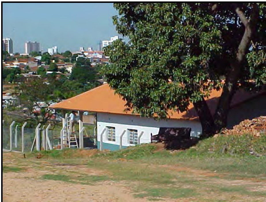
Figura 09: Área Comunitária do CDHU Sítio São Pedro localizada no fundo de vale do córrego da Colônia Mineira: sem utilização atual com previsão de funcionamento para o ano de 2004. Fonte: Pesquisa de Campo (2002). Autora: Adriana Olivia Alves.
