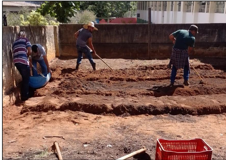
Figura 19: Limpeza e preparação de solo - EE Helen Keller – 04/03/2022
