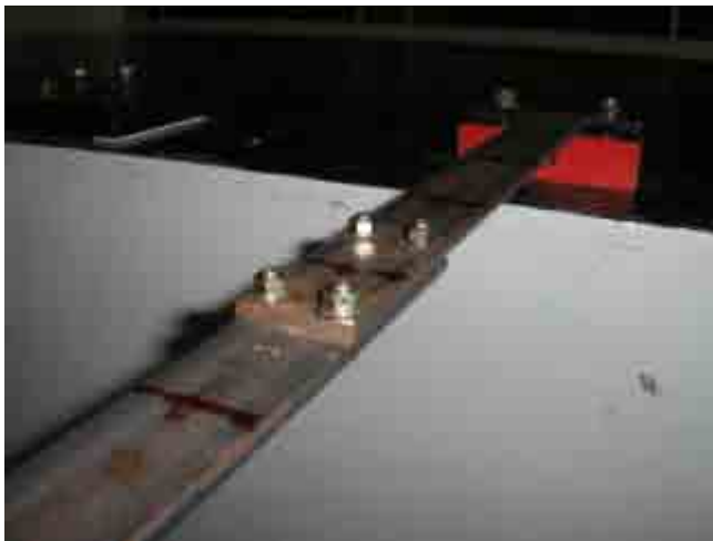
Figura 6.8(a) – Visão de cima da estrutura
