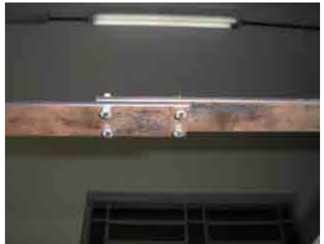
Figura 6.8(b) – Visão de baixo da estrutura
